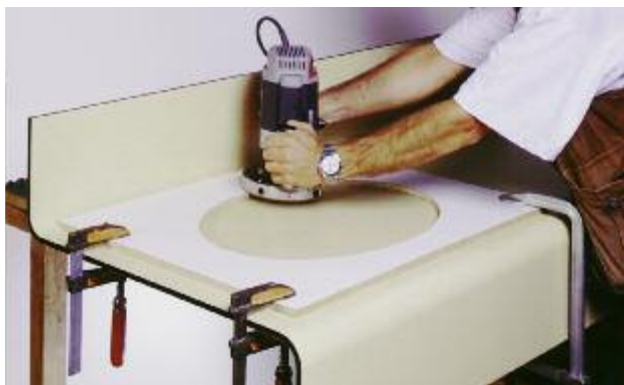
1. Obrysowanie i wycięcie otworu przy pomocy frezarki
